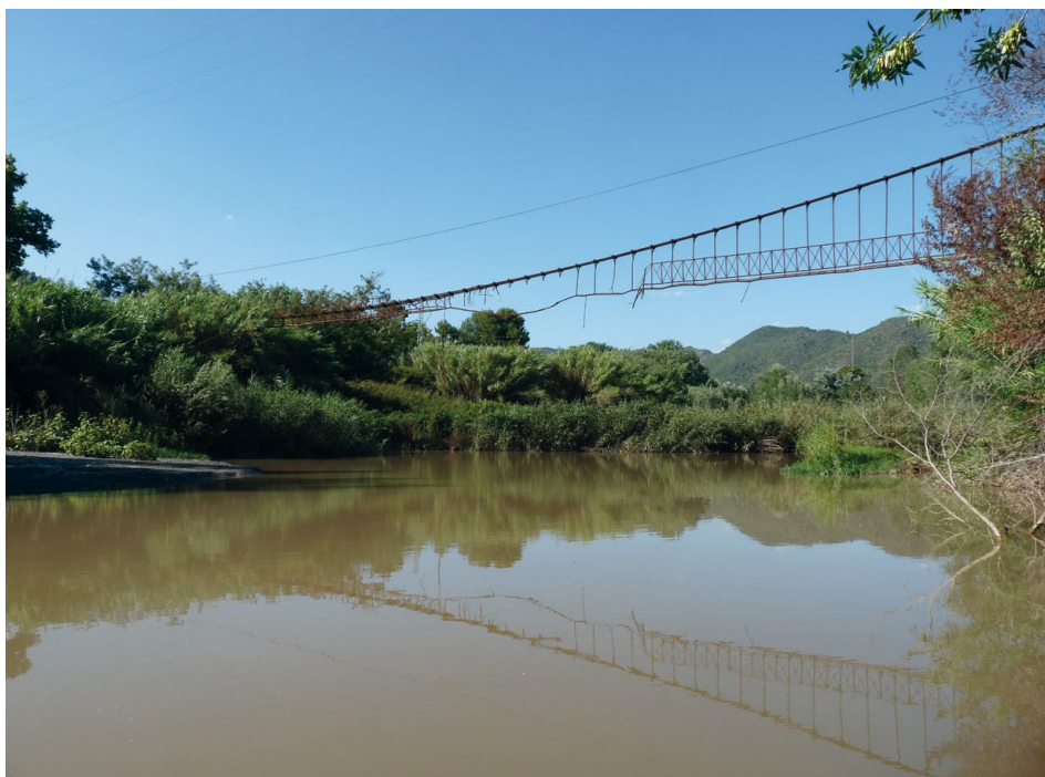
Figura 8. Estat actual de la palanca de la Colònia Sedó i comparació de l'augment de cota del riu
